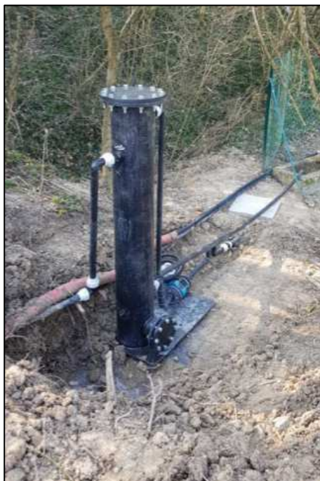
Tête de puits raccordé en définitif
