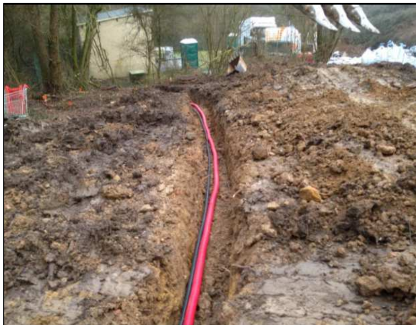
Mise en place du collecteur et de la gaine TPC
