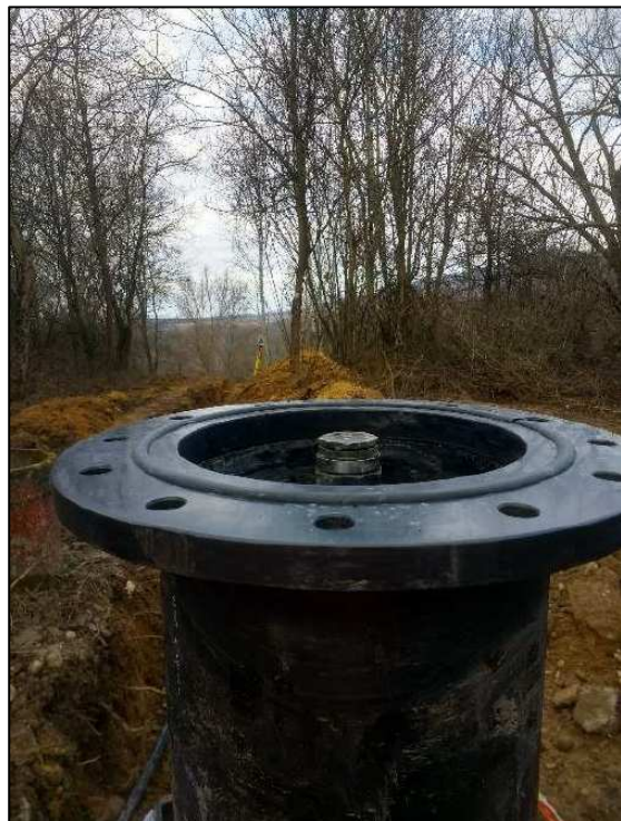
Tête de puits avec filin inox pour sortir la pompe
