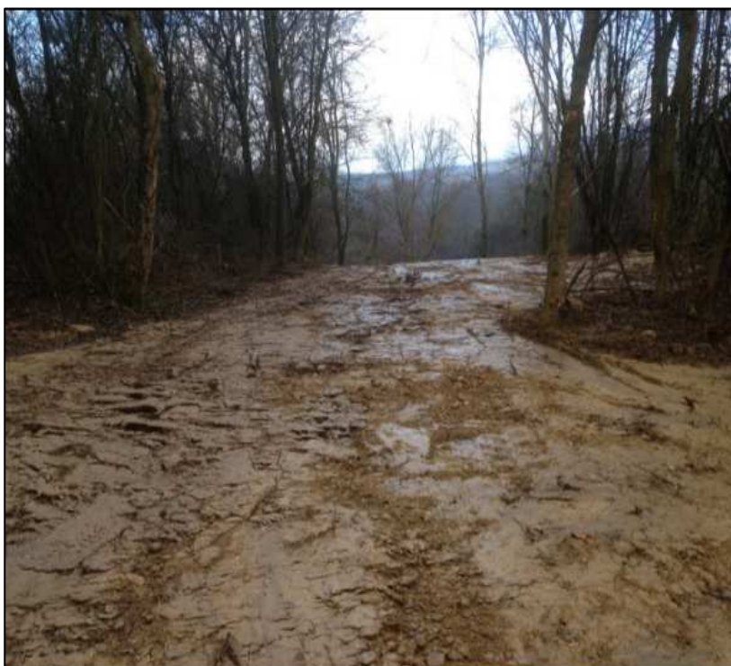
Zone de travaux après remblais et compactage
