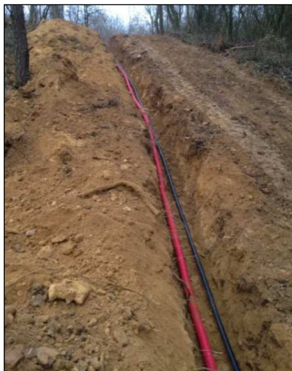
Mise en place du collecteur et de la gaine TPC
