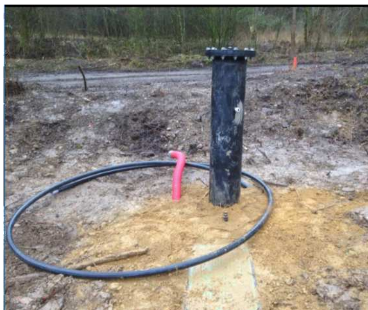
Puits lixiviats munis d'un système de fermeture boulonnée
