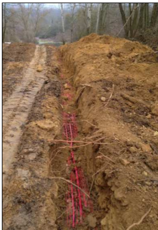
Mise en place du grillage avertisseur
